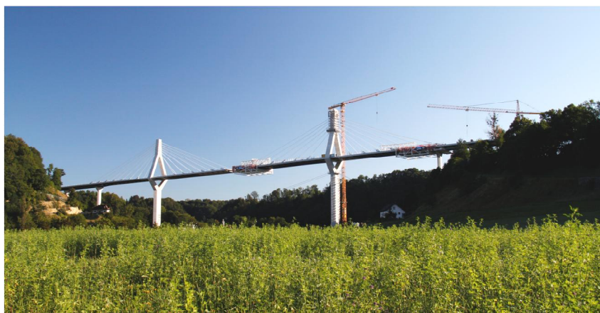
Pont de la Poya, août 2013, photo JDW
